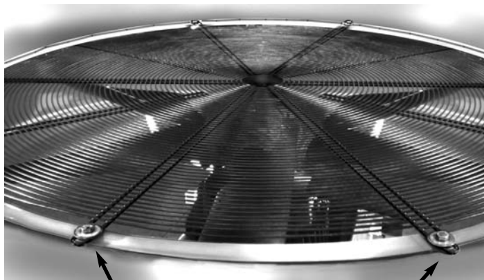
Fig. 2 Removing the fan guard
